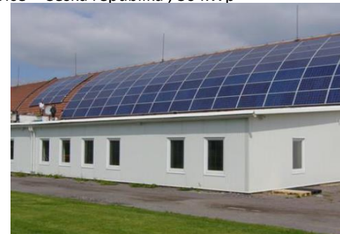
FVE Bořice – Česká republika , 30 kWp
